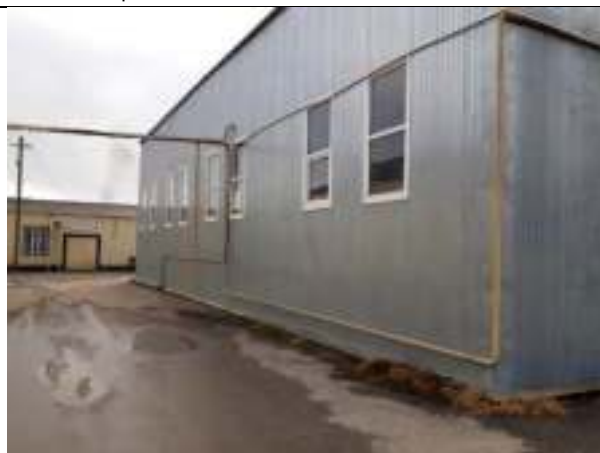
Консервный цех, кадастровый номер: 20:11:0101056:532
