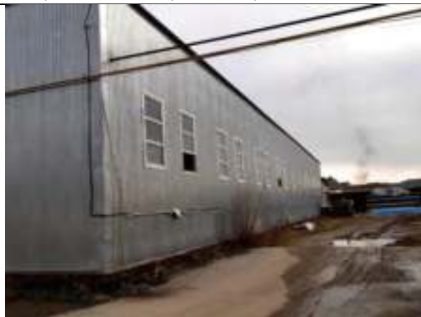
Консервный цех, кадастровый номер: 20:11:0101056:532
