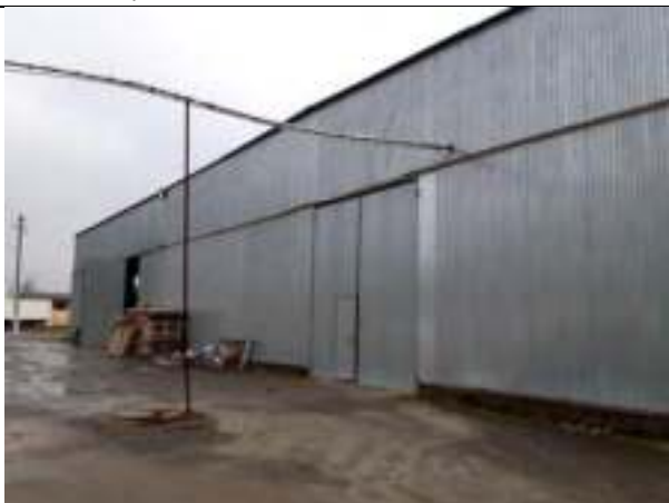
Консервный цех, кадастровый номер: 20:11:0101056:532
